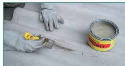
Relleno de la fisura con pegante epóxico
